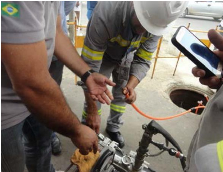
Paso 1: Soplado de microductos (Máquina minijet PLUMET MINI JET H02 Ejemplo real en Brasil)
