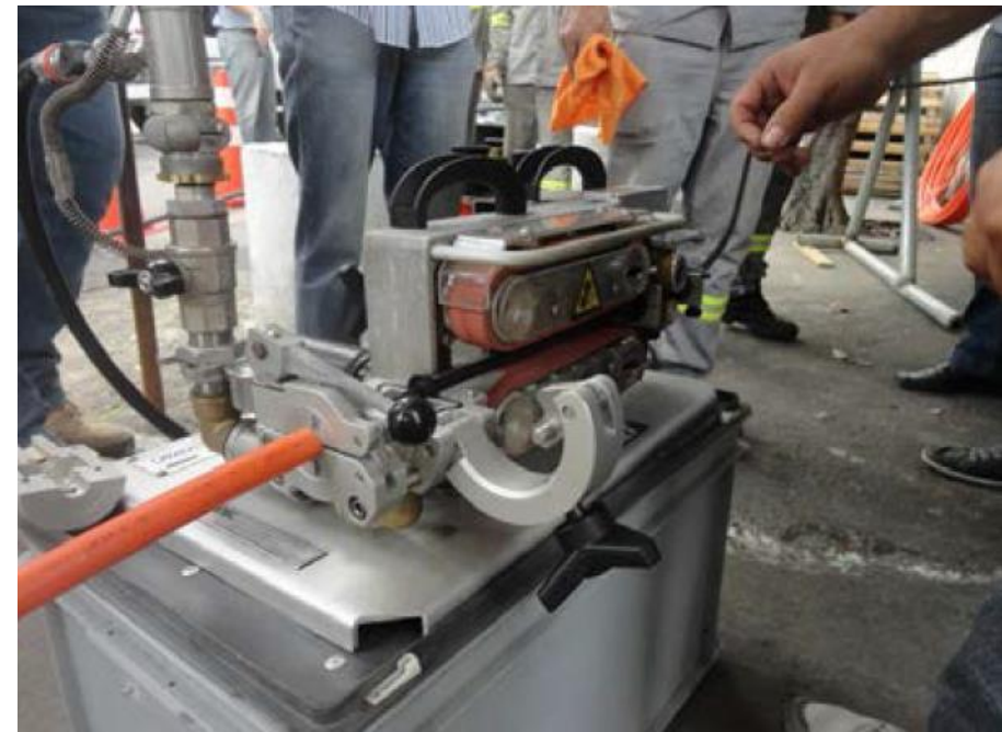
Paso 2: Soplado de cable (Promedio 45-50 m/min)
